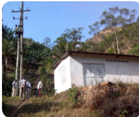
Burundi - centrale idroelettrica
