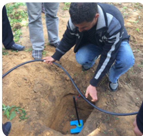
Tunisia, Nabeul - Installazione del Diffusore Interrato
