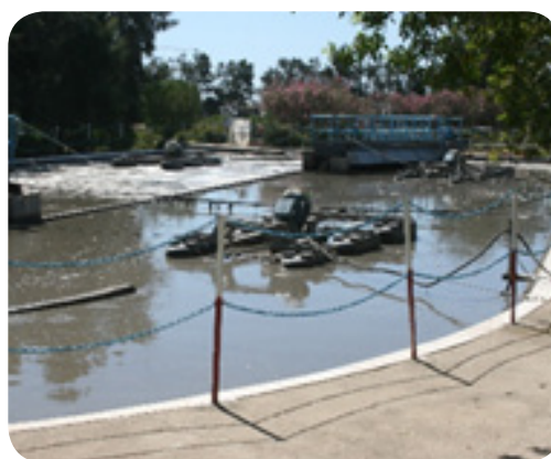
Tunisia, Nabeul - Stazione trattamento acque reflue ONAS
