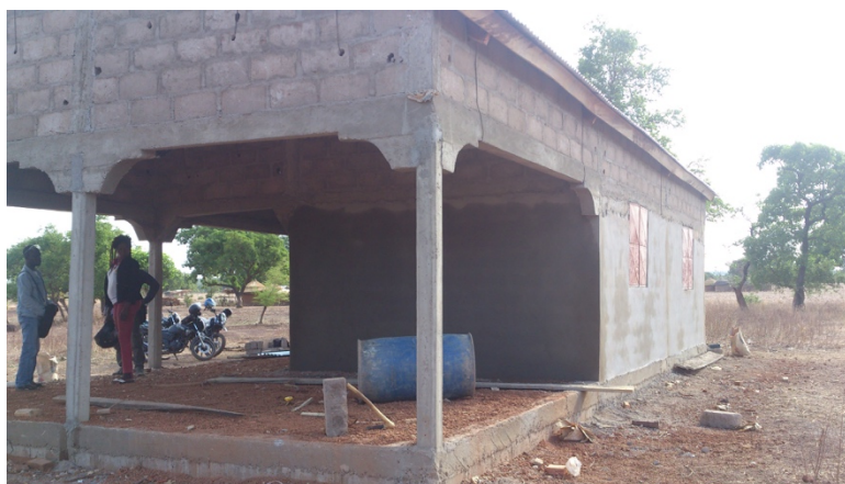
Figura 2 Costruzione della centrale di trasformazione a Naki-Est
