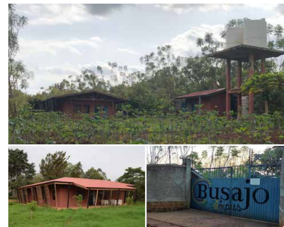
Water tanks e vano tecnico per il generatore, Guest House e Cancellone d'ingresso del Campus
