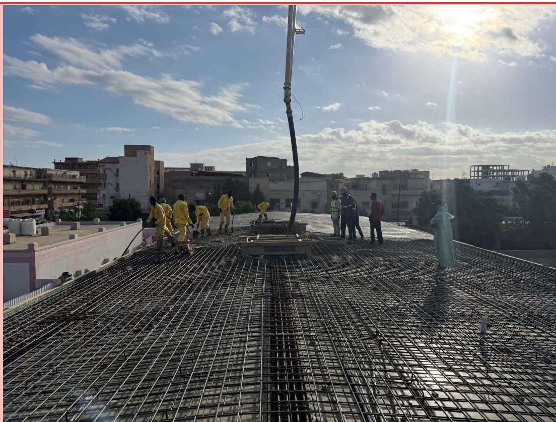
Getto per la realizzazione della copertura del nuovo edificio che ospiterà il reparto di degenza
