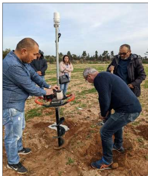
Dicembre 2022, governatorato di Nabeul: Installazione di stazioni agrometeorologiche (PRESTo-Wisper)
