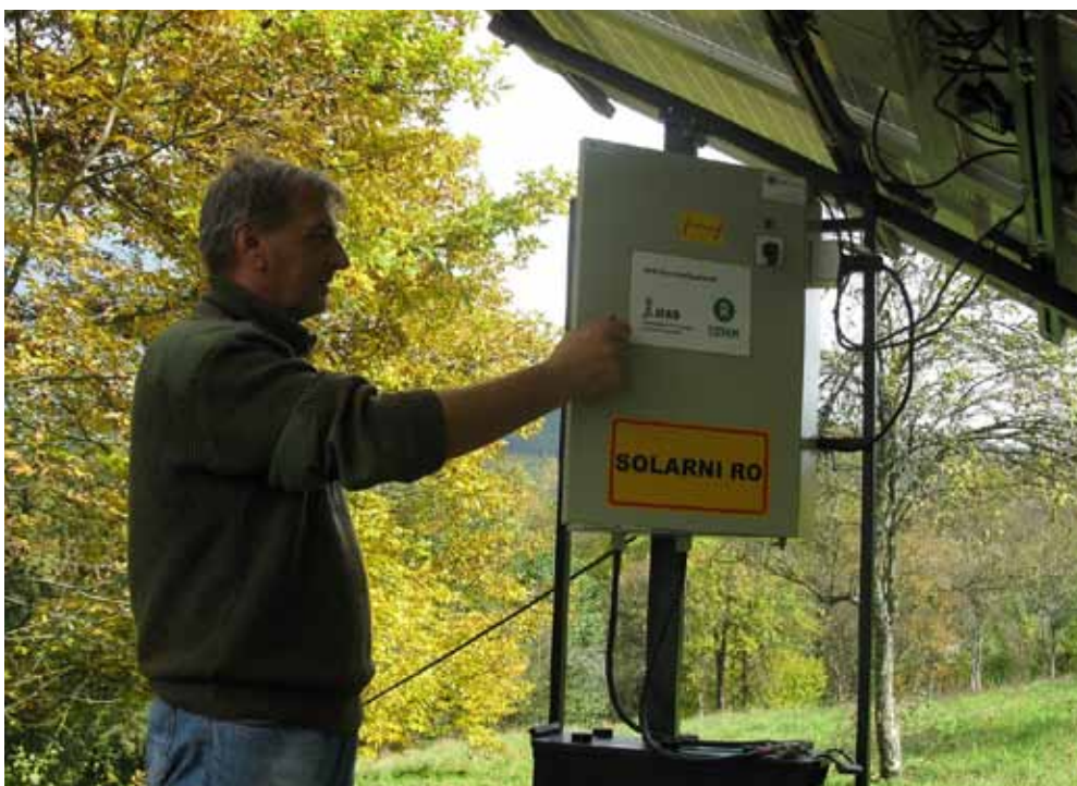
BOSNIA ERZEGOVINA. Installazione dei pannelli solari, che permetteranno agli agricoltori di irrigare i campi grazie a pompe azionate dall'energia solare. Il progetto fa parte di un programma che sostiene i piccoli agricoltori in Albania e Bosnia Erzegovina. Foto: Amna Kurbegovic/Oxfam Italia
