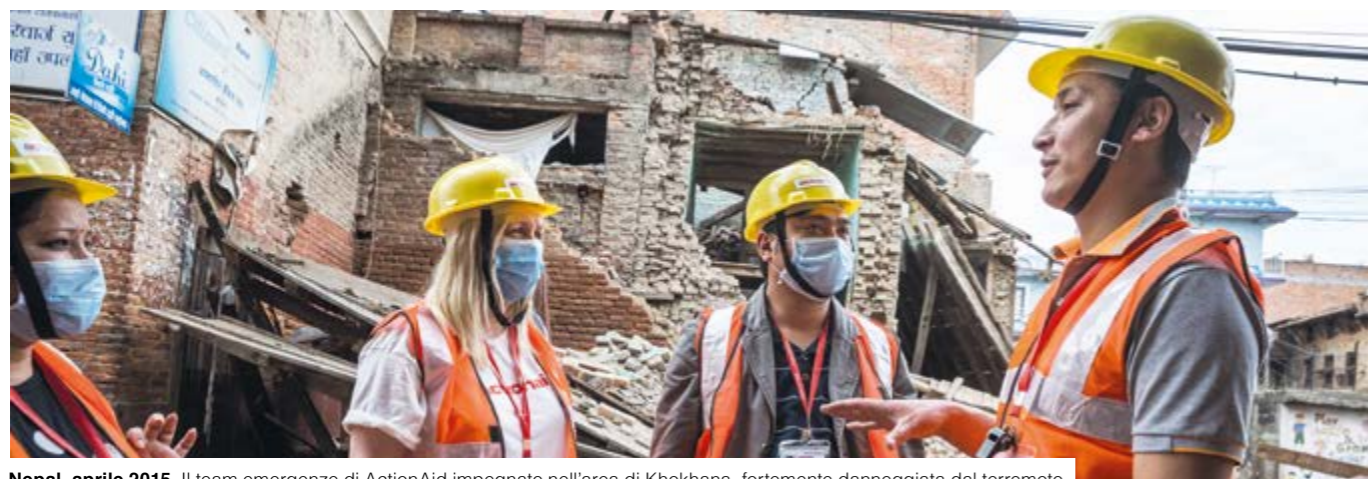
Nepal, aprile 2015. Il team emergenze di ActionAid impegnato nell'area di Khokhana, fortemente danneggiata dal terremoto.
